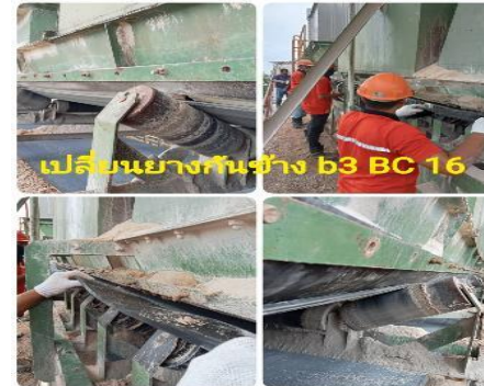
ตรวจสอบหน้างานเปลี่ยนยางกันข้าง B3BC54
